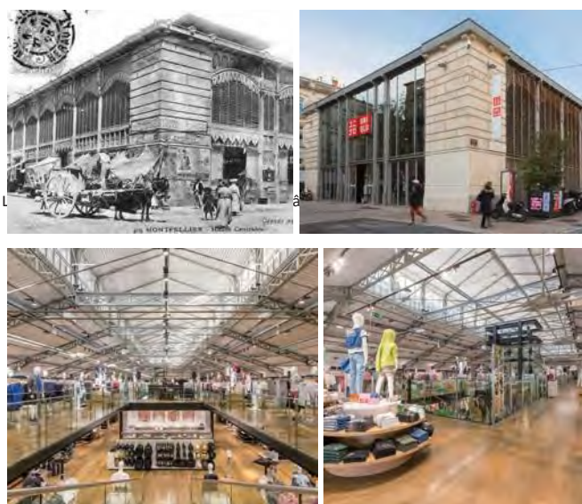
La toiture, trait distinctif du bâtiment, a été préservée.
