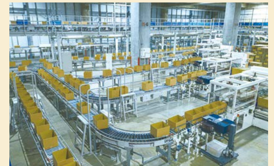
効率的なサプライチェーンを支える自動化倉庫
