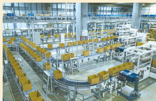
効率的なサプライチェーンを支える自動化倉庫
