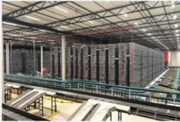
オランダに新設した 床面積11万㎡の自動化倉庫
