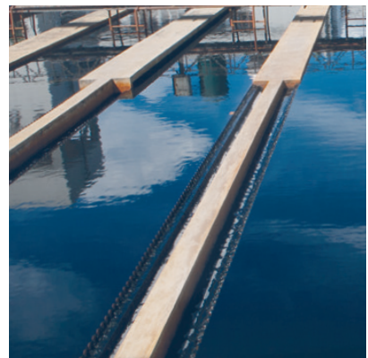
거래기업 공장 배수 처리 시설 중국
