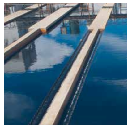
Droite Installation de traitement des eaux d'une usine partenaire, Chine
