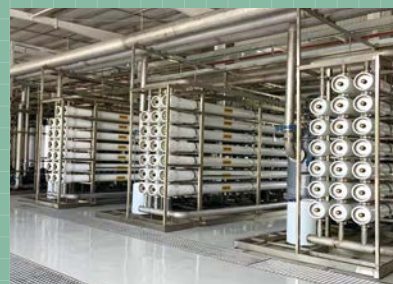
水資源再利用のための 逆浸透膜 (RO) 水再生処理システム
