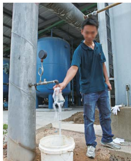
工場内の排水は適切な処理をされて排出されることを随時状況確認しています。
